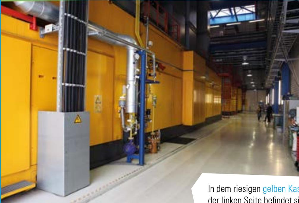
In dem riesigen **gelben Kasten** auf der linken Seite befindet sich eine **Turbine** und ein **Generator**.
