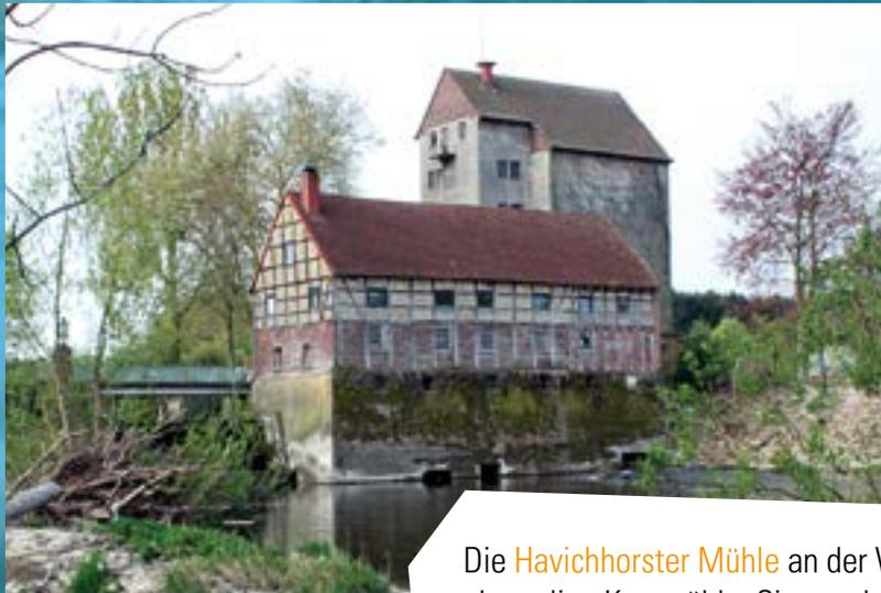
Die **Havichhorster Mühle** an der Werse ist eine ehemalige Kornmühle. Sie wurde vor 600 Jahren gebaut. 1988 wurde sie von den Stadtwerken Münster zu einem Wasserkraftwerk umgerüstet. Seitdem erzeugt sie jährlich 240.000 kWh Strom – ohne ein Gramm CO<sub>2</sub>!
